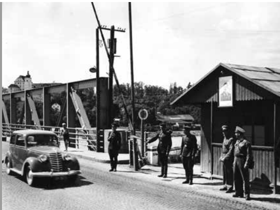
Österreich war von 1945 bis 1955 unter alliierter Besatzung (Die Abb. zeigt einen Zonenübergang).
