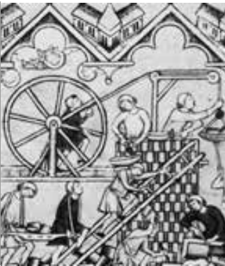
Bauarbeiter in der Mitte des 13. Jhds. Die Bauzünfte gehörten zu den einflussreichsten Zünften.
